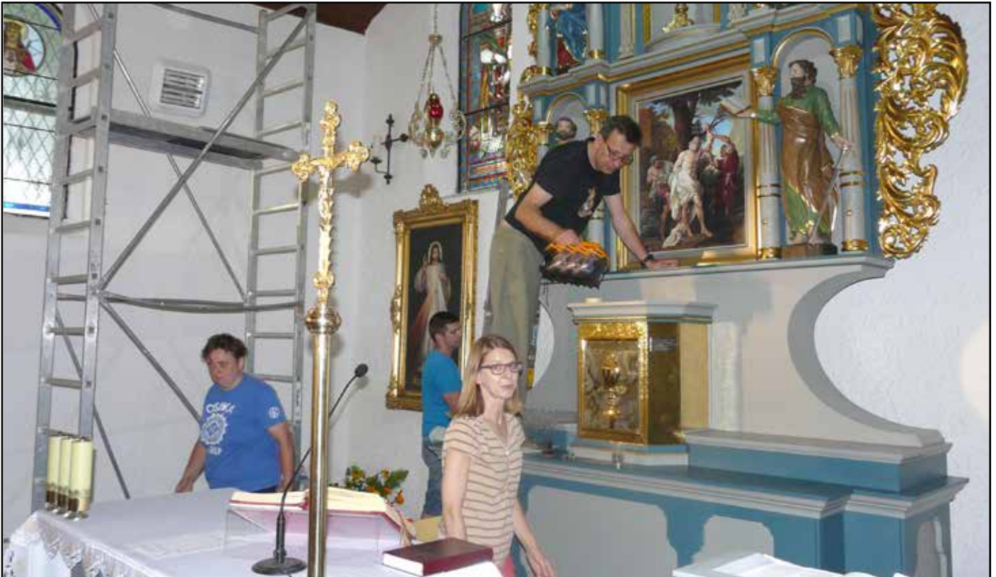
Prace przy ołtarzu św. Bartłomieja Apostoła w Mierzeszynie. Montaż figur ołtarzowych, 25 lipca 2016 roku.
